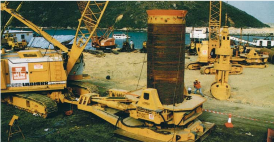
Verrohrungsmaschine \varnothing 2000 mm im Einsatz in Hong Kong Hydraulic casing oscillator, \varnothing = 2000 mm in operation in Hong Kong
